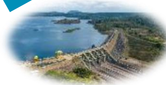
UHE Pedra do Cavalo, Brazil
