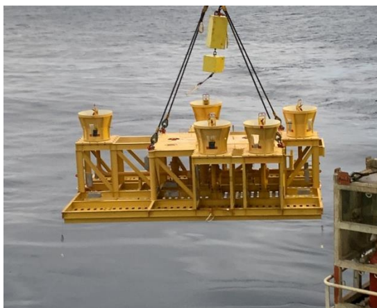
PLEM (esq) e MPP (dir) sendo instalados no Campo de Atlanta
