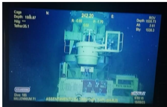
Foto 2 – Árvore de Natal instalada no poço #6
