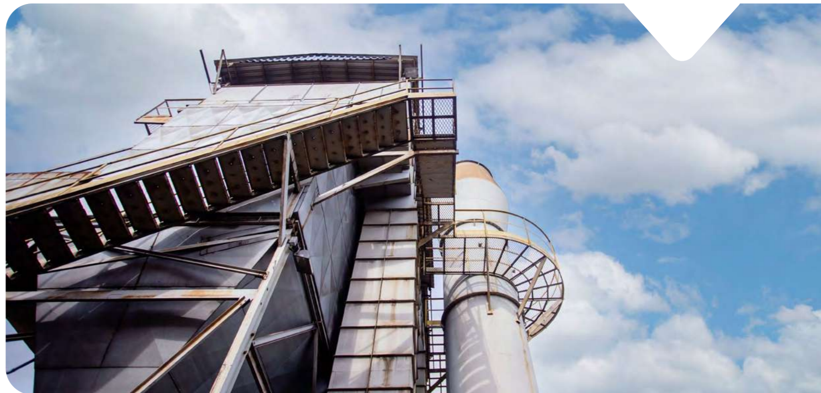
Um dos sistemas de controle de emissões atmosféricas
