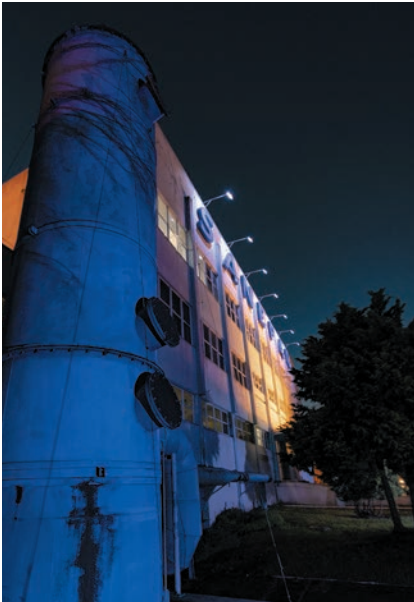
Estação de Tratamento de Água Iguaçu - Curitiba/PR
