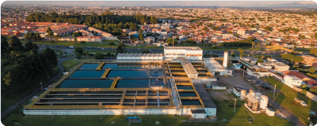
Estação de Tratamento de Água Iguaçu - Curitiba/PR
