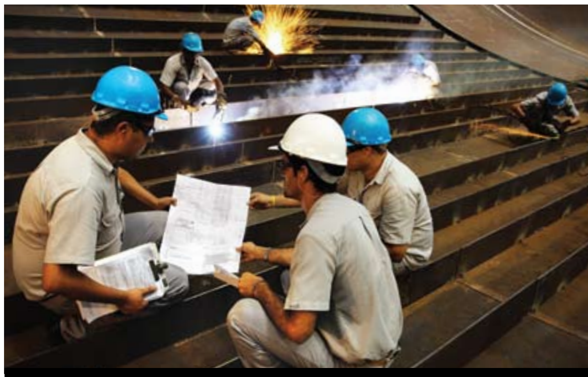
Montagem de Comporta de Hidrelétrica - Usiminas Mecânica.
