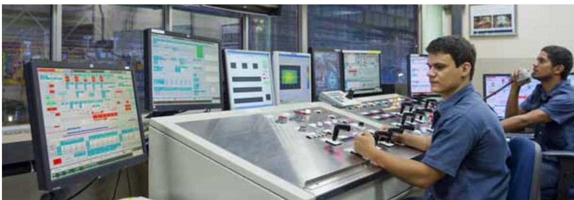
Wellington José Ramos e Brunietas Ferreira Miranda – Sala de Controle – CLC – Usina de Ipatinga/MG
