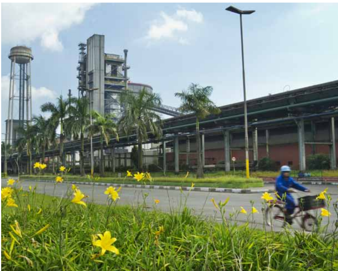
Usina de Cubatão/SP
