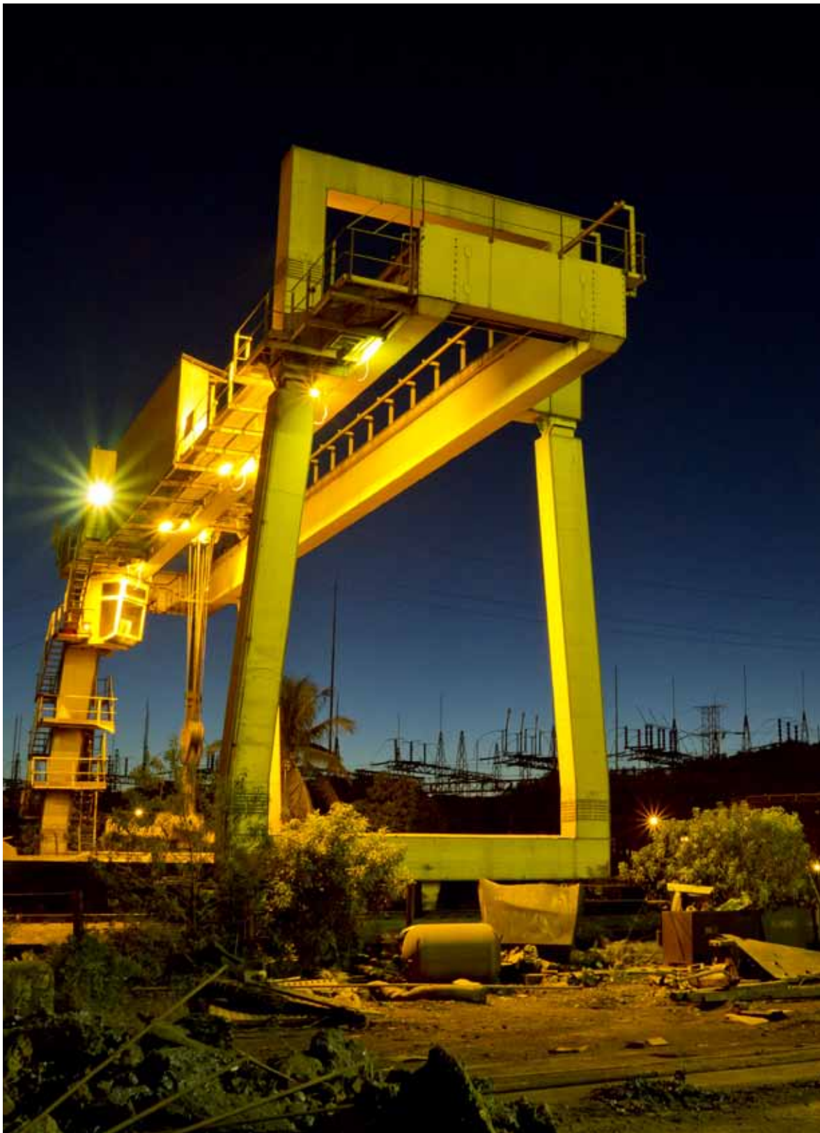
Vista noturna do pórtico do Pátio de Sucatas – Usina de Ipatinga/MG
