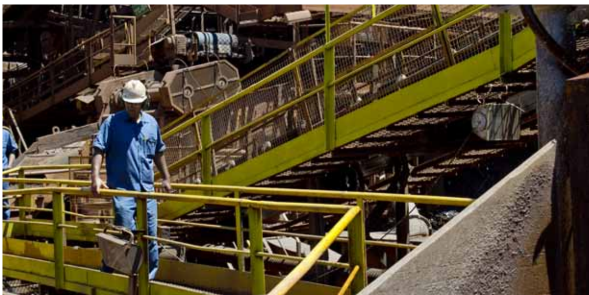
Área de Beneficiamento – Mineração Usiminas – Itatiaiuçu/MG
