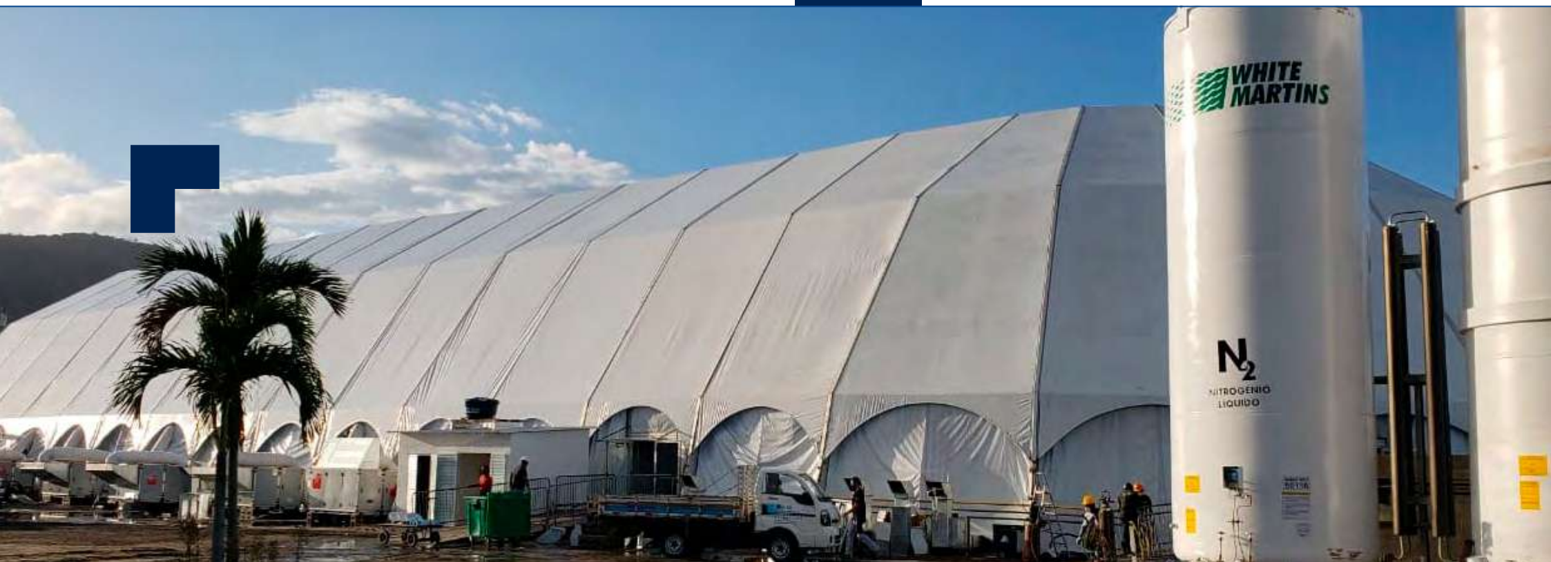
Parque dos Atletas Field Hospital, Rio de Janeiro /RJ
