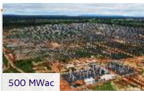
Sol de Jaíba SOLAR
