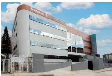
Novo Hospital Lifecenter Contagem/MG – abr'23
