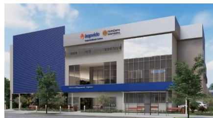
Novo Pronto Socorro Autônomo do Contorno/MG – abr'23
