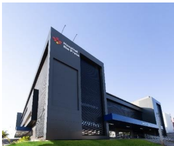
Hospital Rio Preto – São José do Rio Preto/SP – out'23
