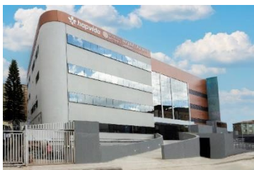
Novo Hospital Lifecenter Contagem/MG – abr'23
