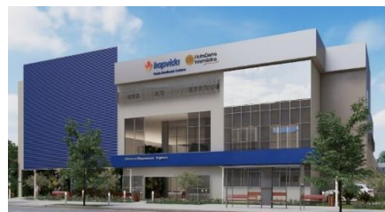
Novo Pronto Socorro Autônomo do Contorno/MG – abr'23
