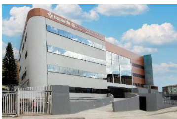
Lifecenter Contagem Hospital/MG – apr'23
