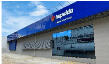
Nova Clínica Setor Oeste (GO)
