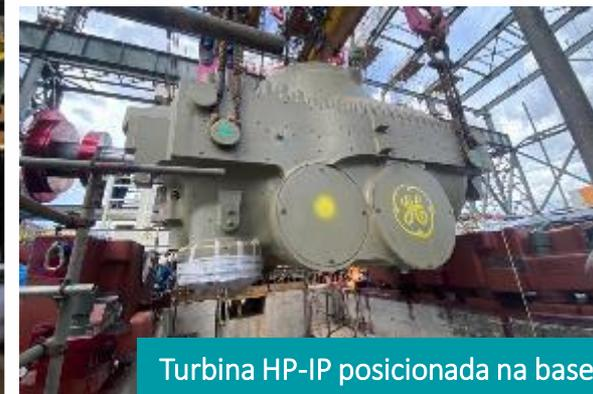
Turbina HP-IP posicionada na base
