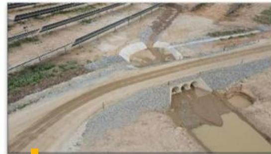
Escavação das canaletas de drenagem e lançamento de cabos de baixa tensão
