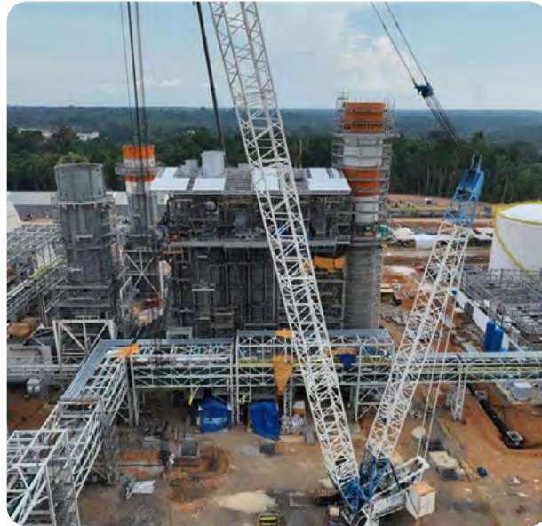
Montagem de módulos de pipe rack de Azulão 950; no total, são 18 peças de aço carbono, com 354 toneladas, o equivalente ao peso de quase 250 carros populares
