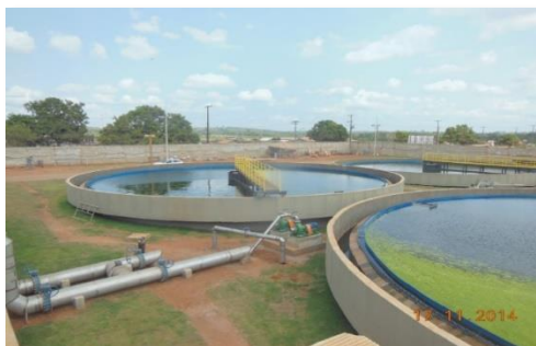
Construção da ETE de Altamira
