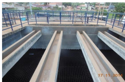
Reforma e Ampliação da ETA Altamira
