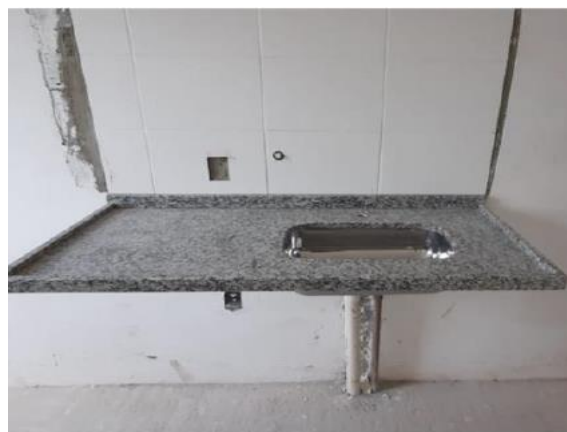
Instalação das bancadas
