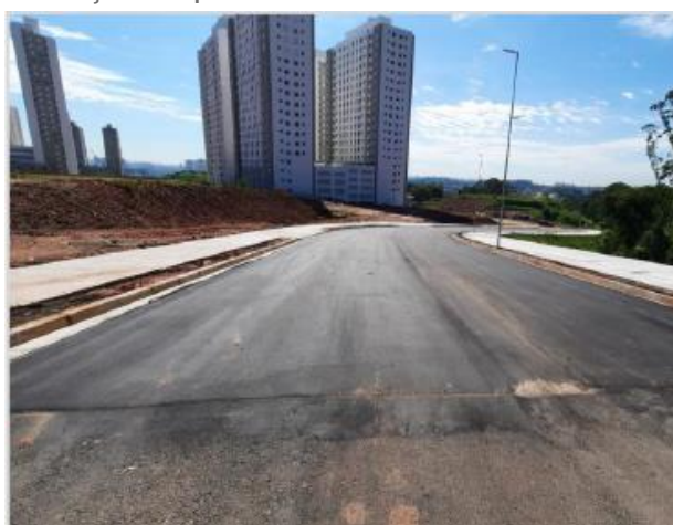
Execução do pavimento na rua 9
