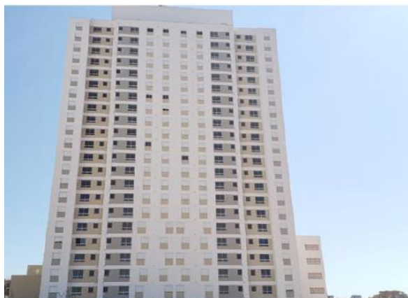
Vista da Fachada – Torre B
