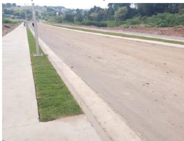
Colocação de Grama nos passeios da Av. 01
