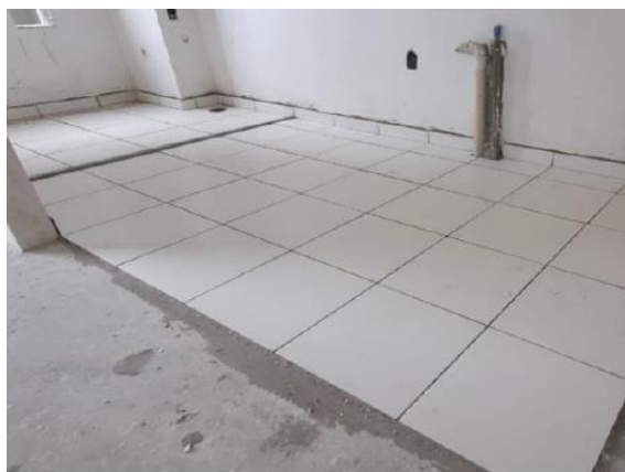
Execução de piso cerâmico
