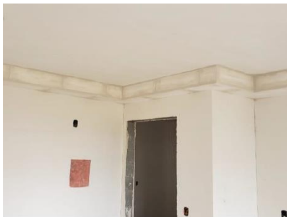
Execução das sancas de gesso
