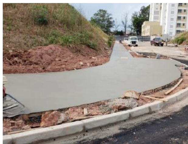
Concretagem e passeio da rua 10
