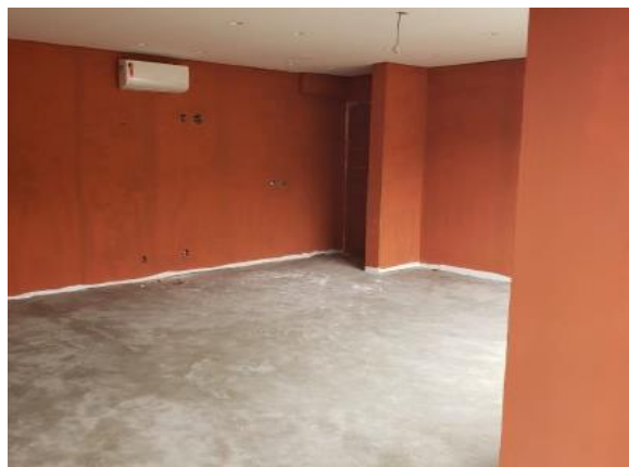
Execução da 1ª demão de pintura do fitness
