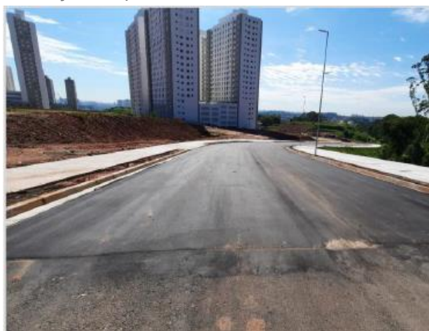
Execução do pavimento na rua 9
