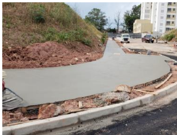
Concretagem e passeio da rua 10
