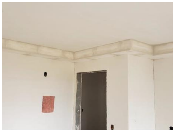
Execução das sancas de gesso
