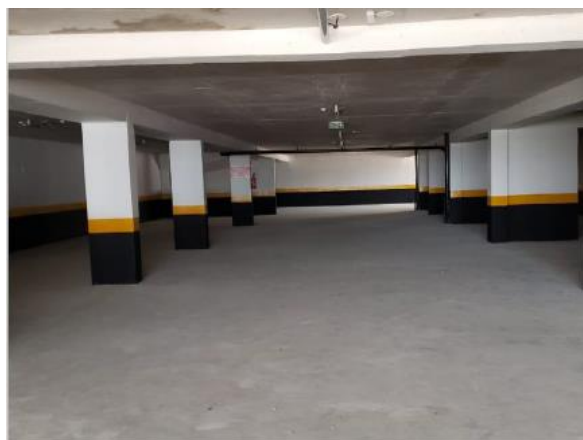
Finalização da pintura da garagem
