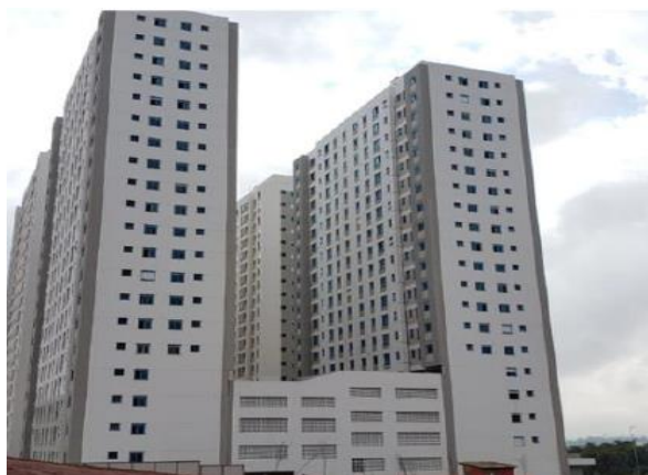
Vista Geral das Torres
