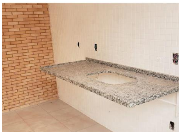
Instalação da bancada do Gourmet
