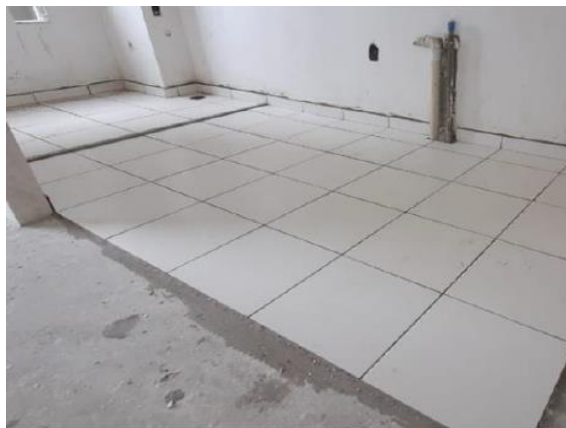
Execução de piso cerâmico
