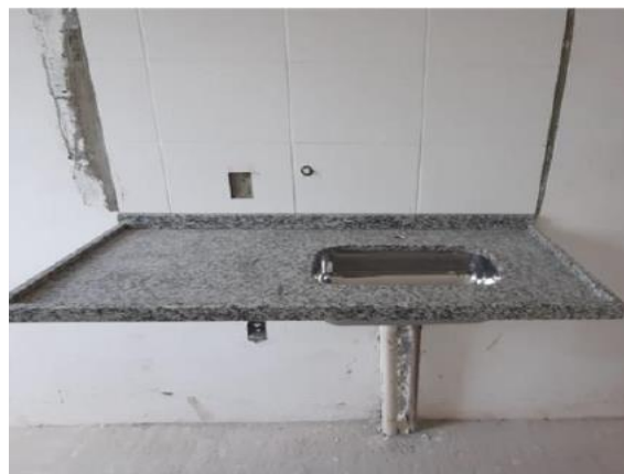
Instalação das bancadas
