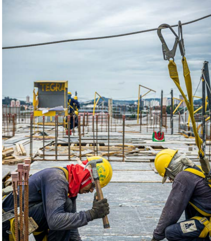
OBRA EMPREENDIMENTO TEGRA ELO
