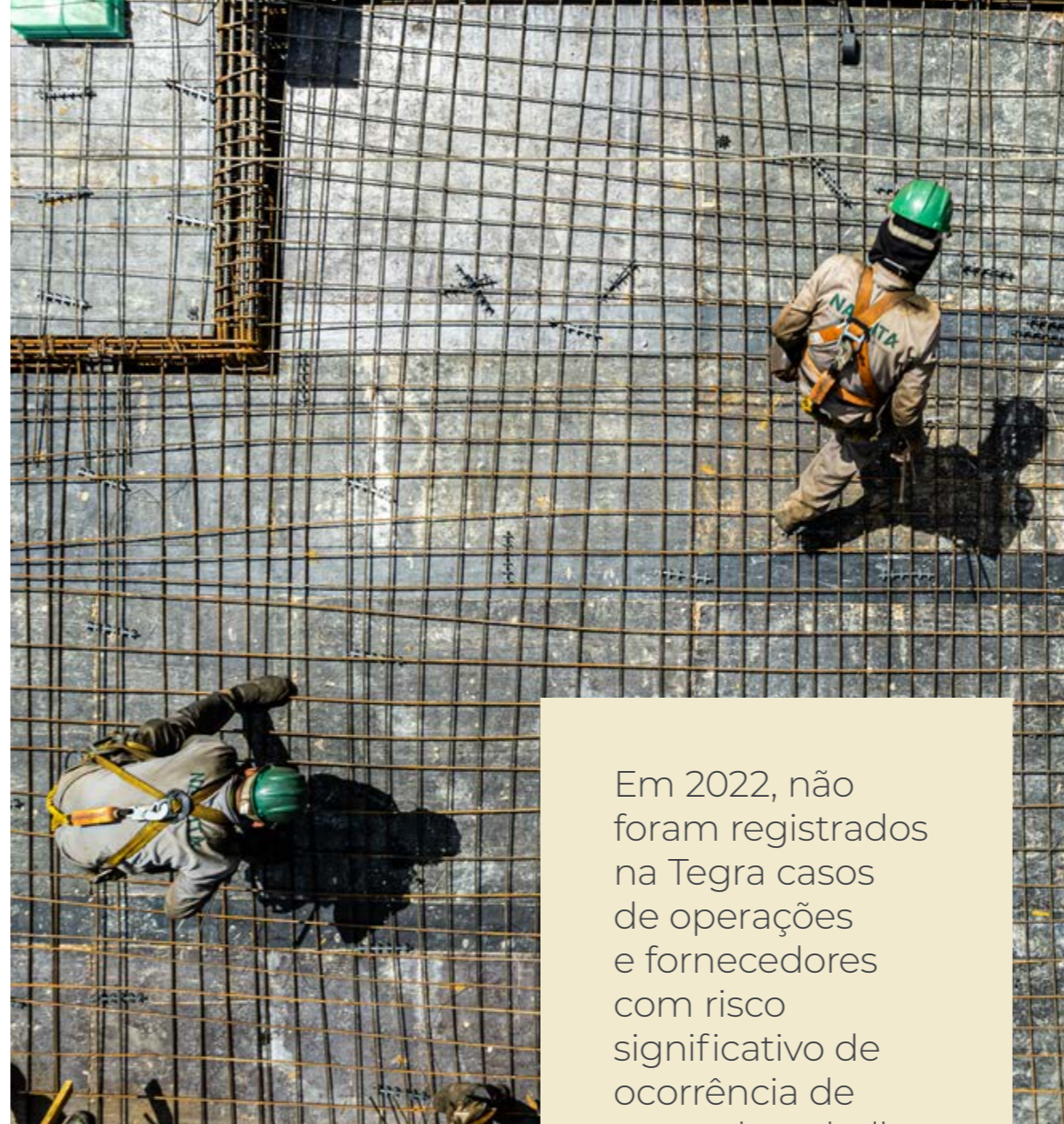
OBRA EMPREENDIMENTO TEGRA GRAVURA
