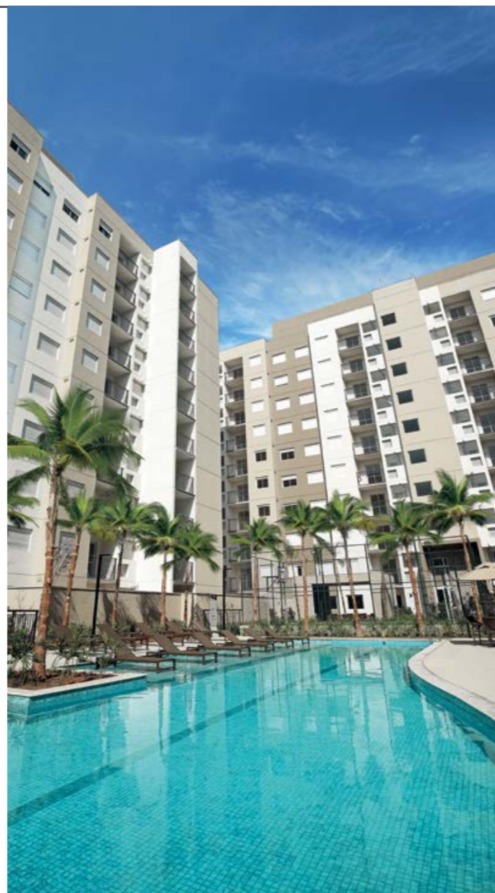
OBRA EMPREENDIMENTO TEGRA CORAZZA
