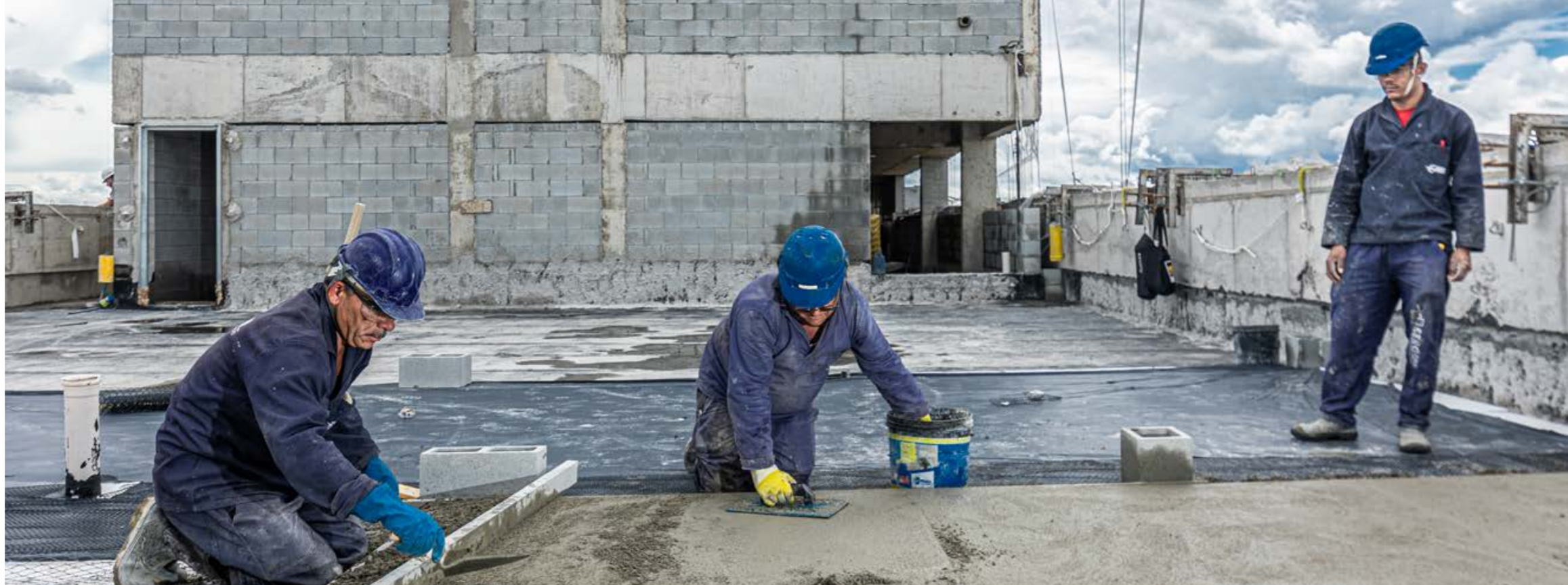
OBRA EMPREENDIMENTO NEO BROOKLIN
