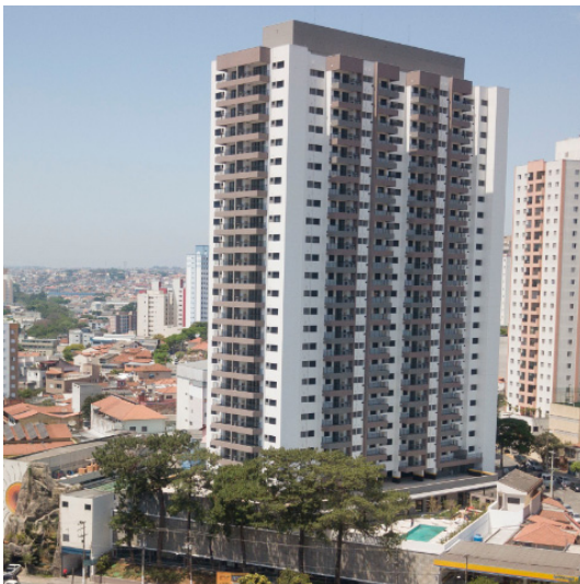
Figura 1: Fachada – Raízes Vila Matilde
