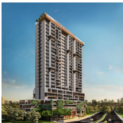
Figura 4: Fachada – Haus Brooklin
