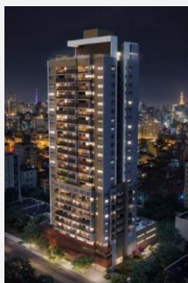
Haus Mitre Santa Cruz Rua Assungui, 121 Alto do Ipiranga – São Paulo VGV: R$ 119 milhões Unidades: 158 Lançamento: Mar/21 % VGV Vendido: 34%
