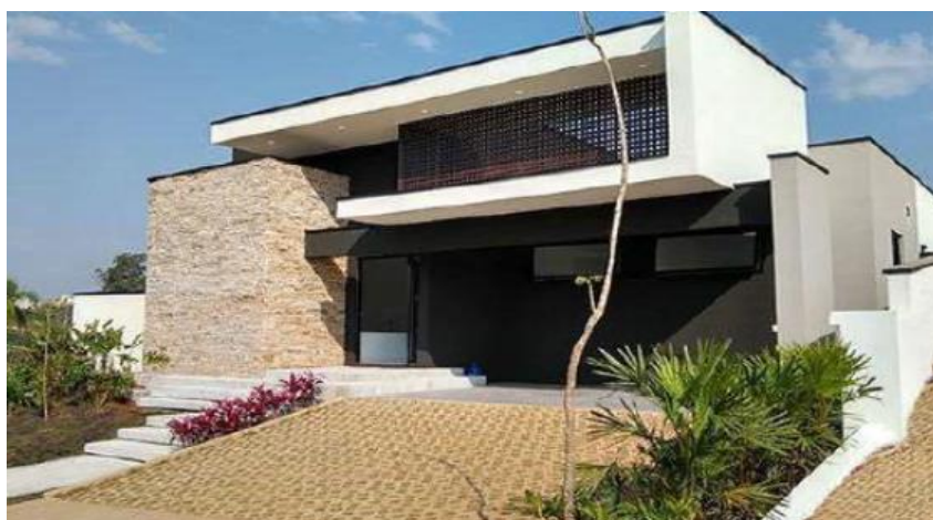
Casa modelo construída no empreendimento Nova Esplanada 4, Votorantim/SP. Prazo de construção – 4,5 meses. Tecnologia utilizada – steel frame.
