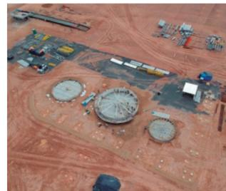
Montagem dos tanques da estação de tratamento de água - ETA.
