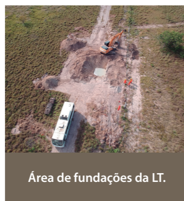
Fundações concretadas para instalação da torre.
