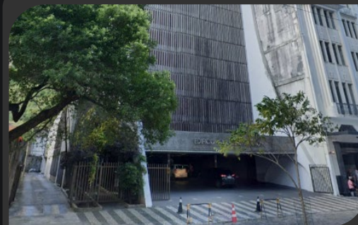
Edifício Garagem Aliança – BA
