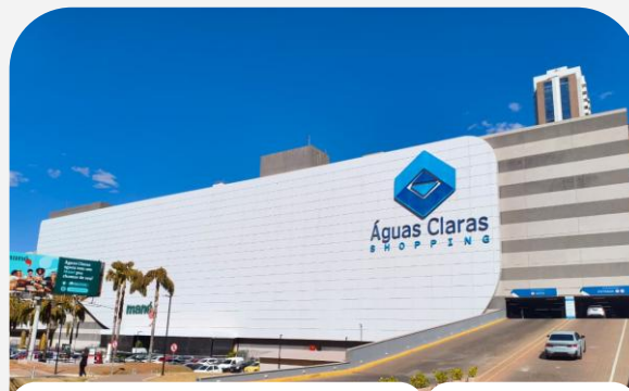
DISTRITO FEDERAL Águas Claras Shopping Mall
