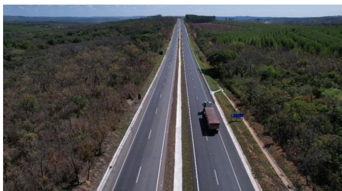
Eco135 Duplicação da rodovia
