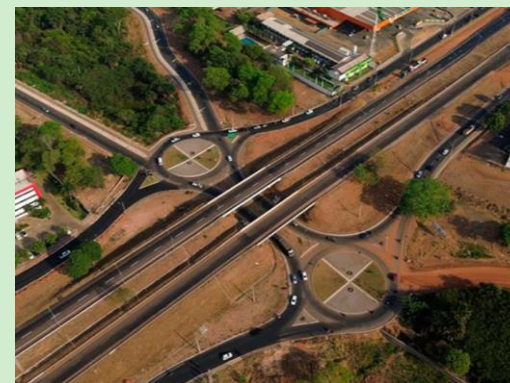
Ecovias do Araguaia: obras de duplicação em Gurupi/TO
