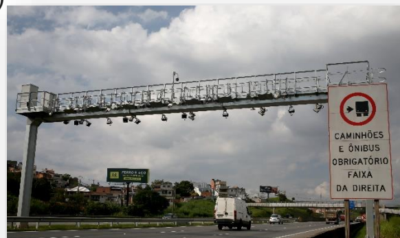
Pórtico Free Flow em teste na Ecopistas
