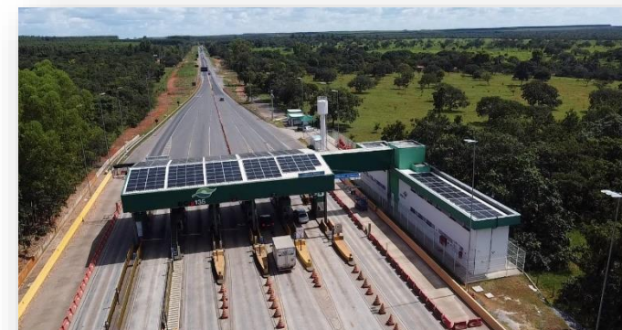
Painéis fotovoltaicos instalados em praça de pedágio da Eco135
