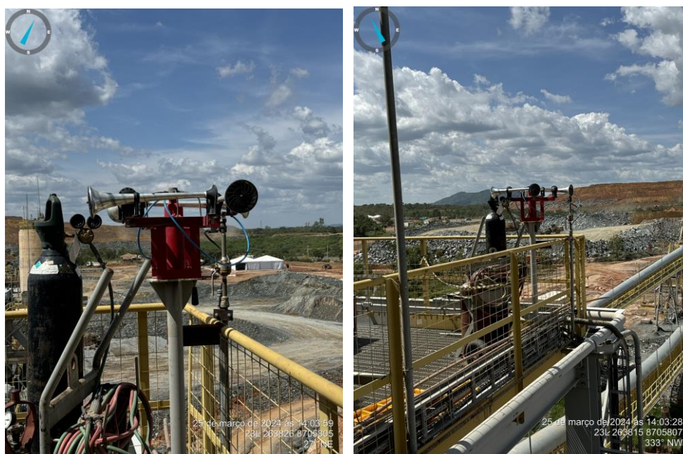
Figura 10.1 – Instalação da sirene de alerta sonoro na planta de beneficiamento.
