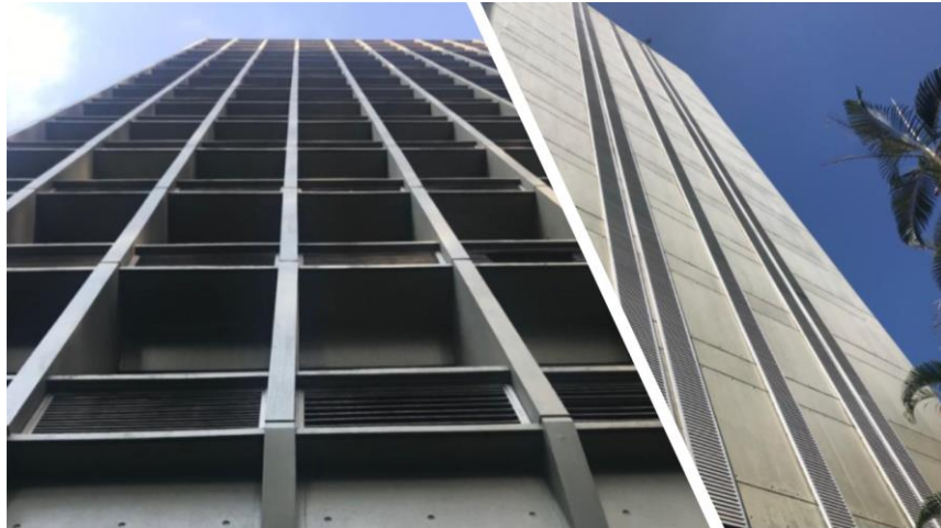
Fachada atual em visão frontal e lateral do edifício Haddock Lobo (antes do retrofit)
