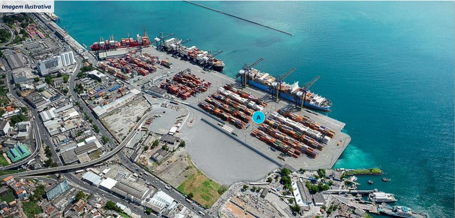
Visão Geral do Terminal Após a Conclusão do Segundo Estágio do Plano de Capex
