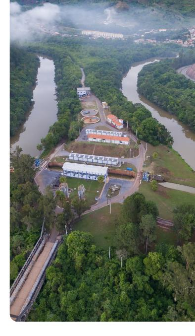
O tratamento da água bruta captada, realizado nas Estações de Tratamento de Água (ETA), é composto pelas etapas de coagulação, floculação, decantação, filtração, cloração, fluoretação e correção de pH.
