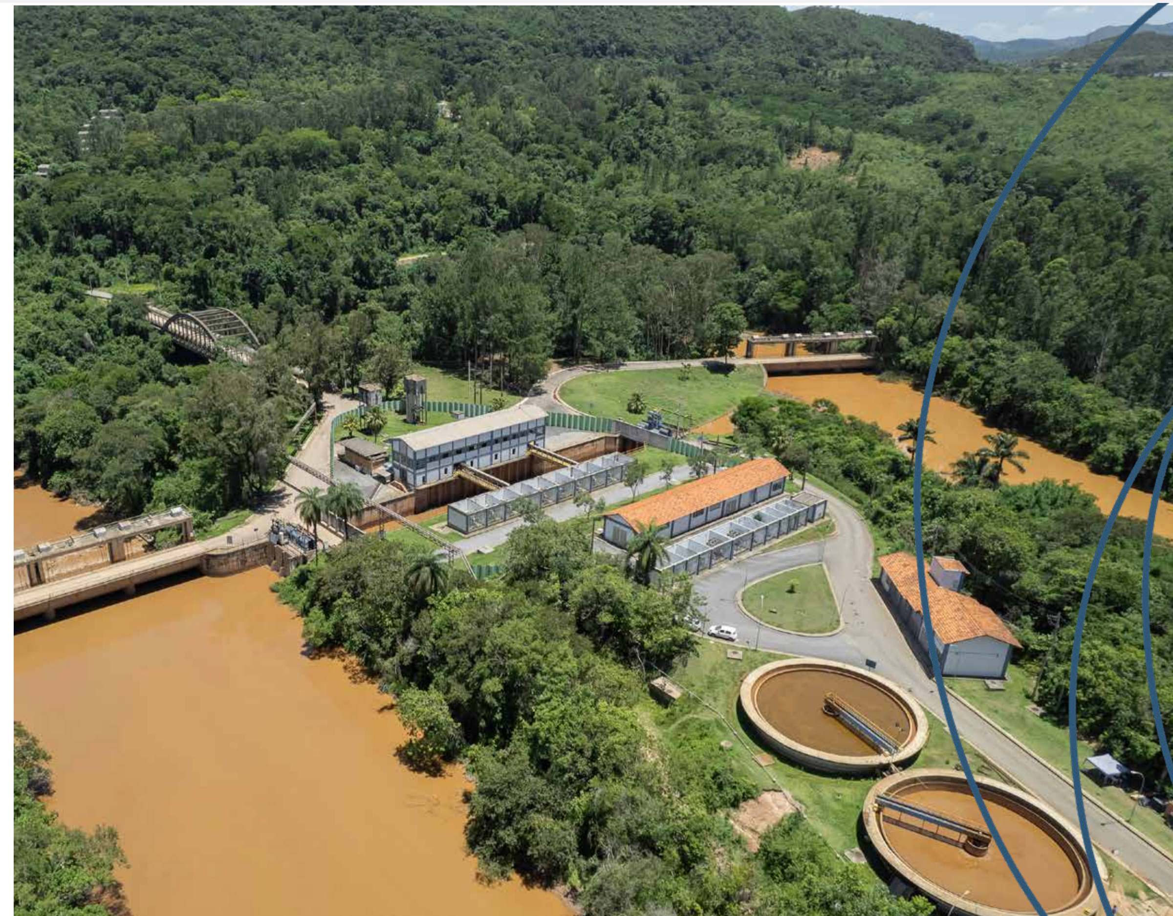
Copasa, Rio das Velhas WTP
