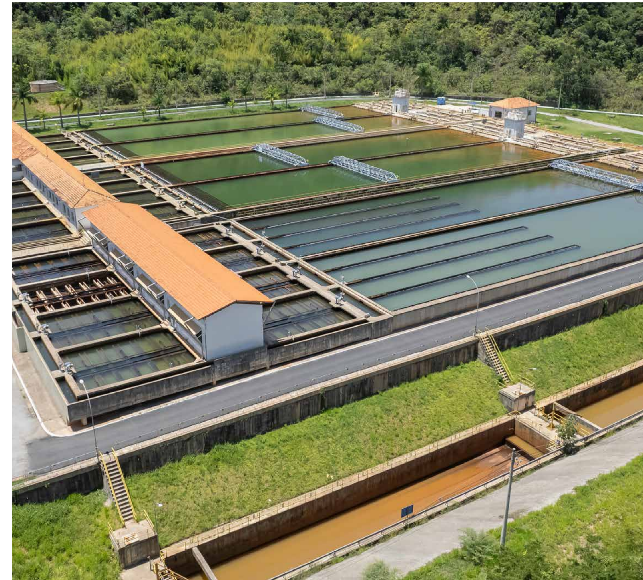
Copasa, Rio das Velhas WTP
