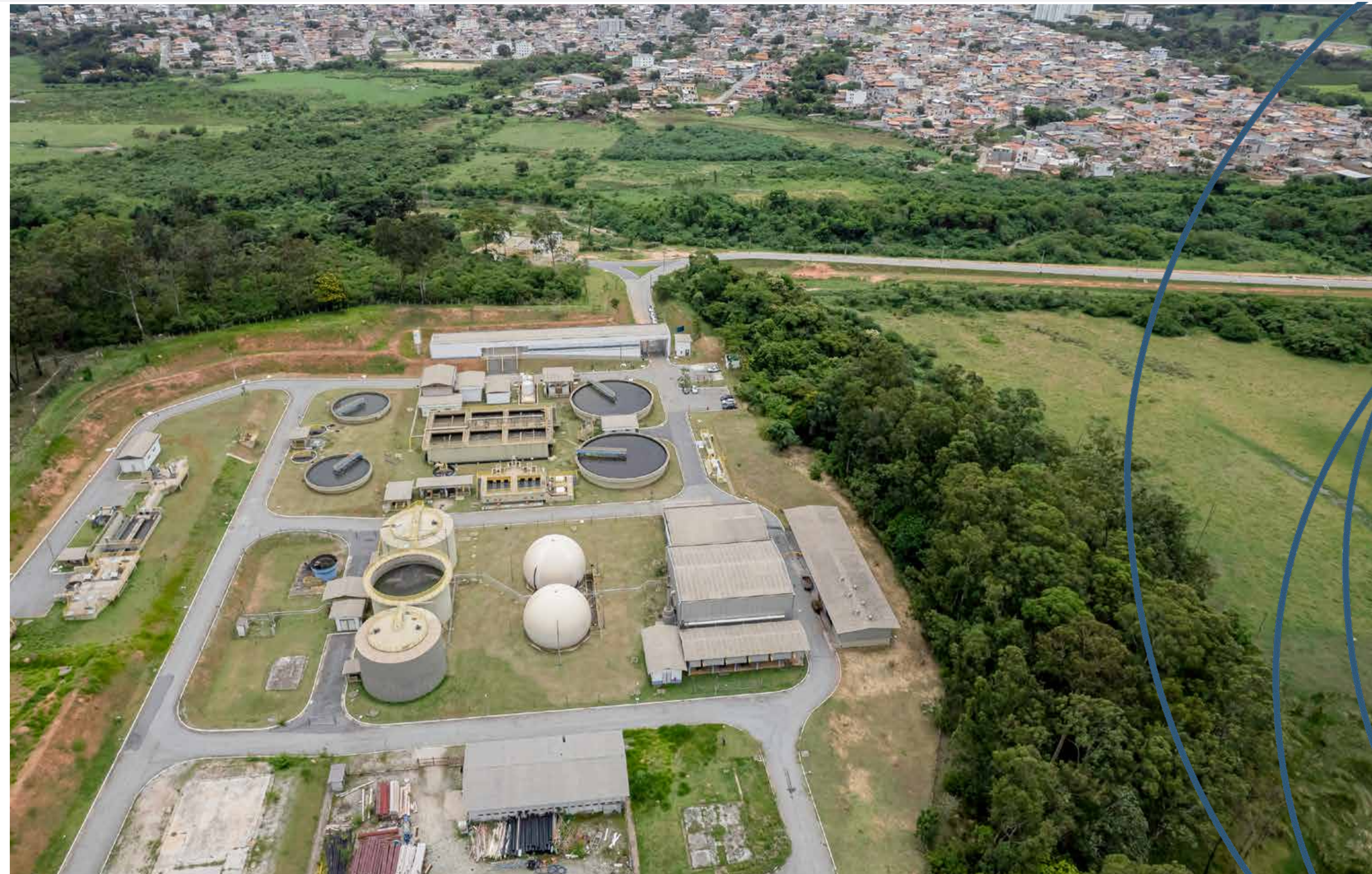
Copasa, Ibirité WWTP
