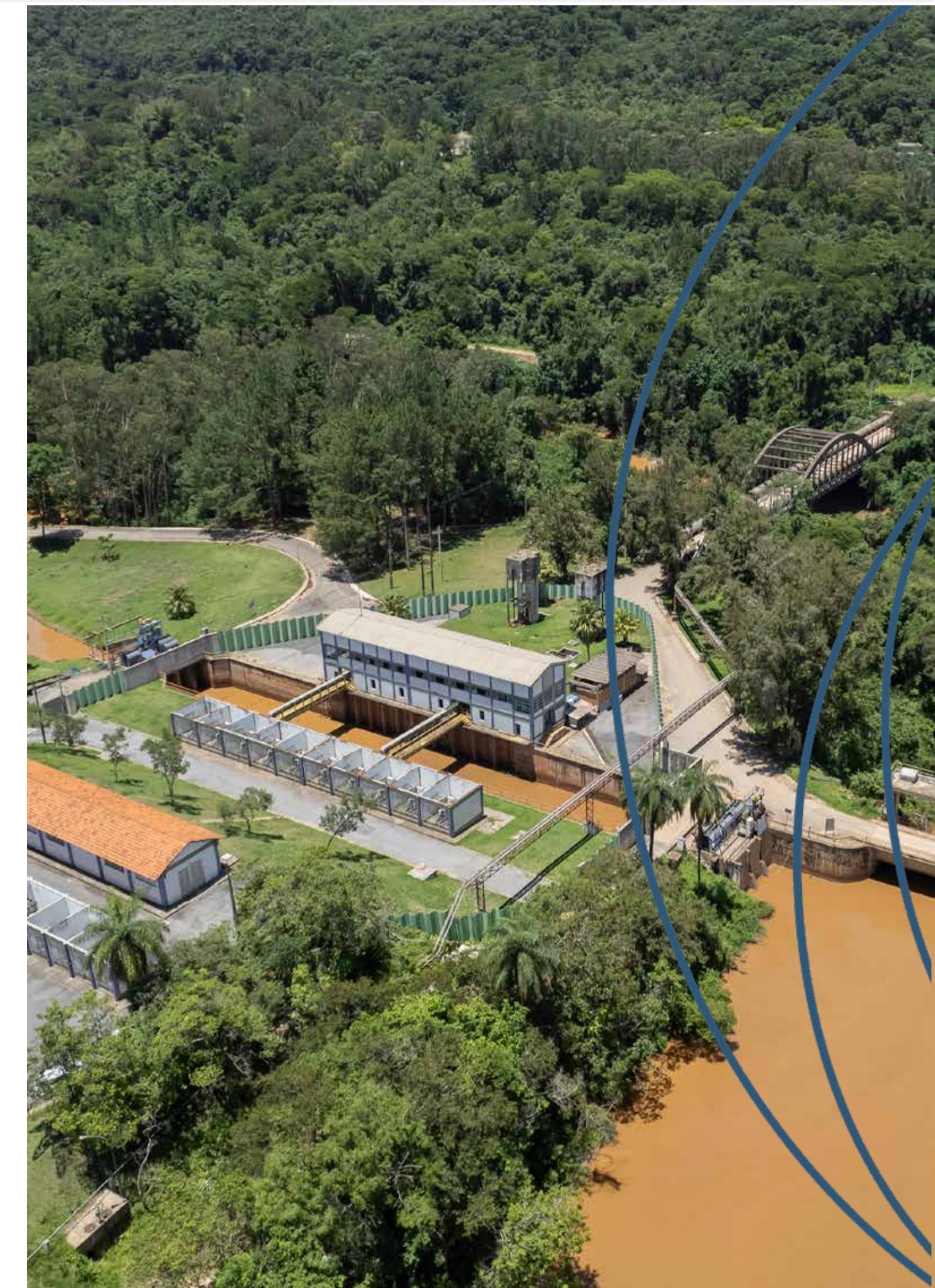
Copasa, Rio das Velhas WTP
