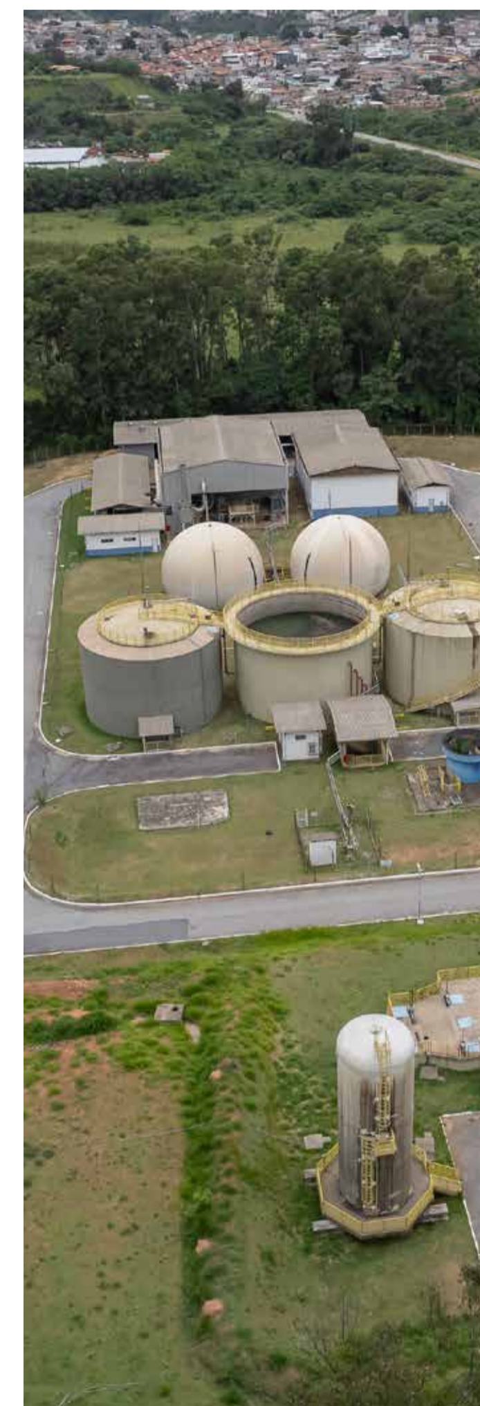
Copasa, Ibirité WWTP
