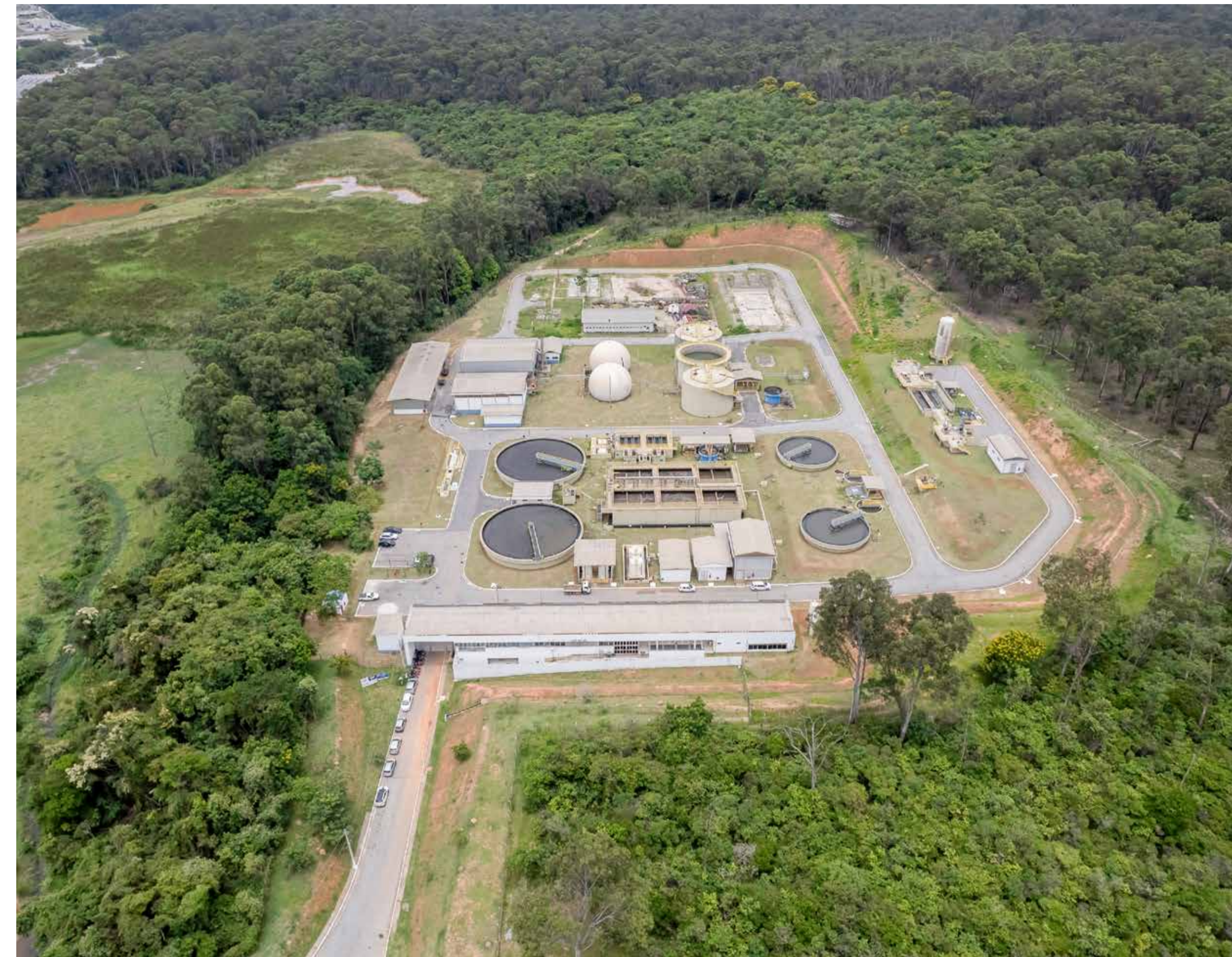
Copasa, Ibirité WWTP
