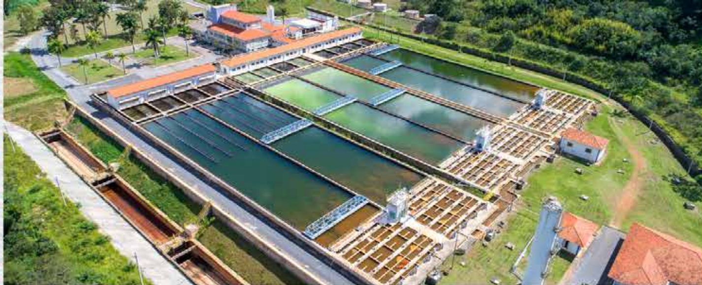
ETA Rio das Velhas - Nova Lima
