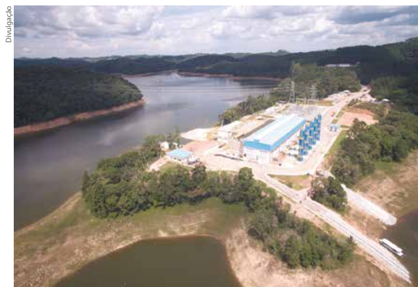
Para garantir segurança hídrica, Sabesp fez 35 obras de grande porte em São Paulo
