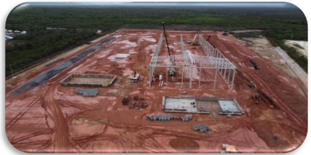
Construção Caucaia-CE (Dez/22)
