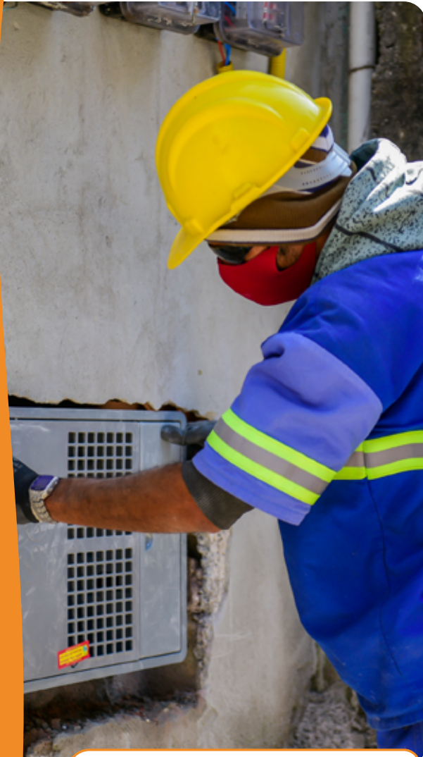
Obras de regularização do sistema de abastecimento no jardim Savoyzinho, Zona Leste do município de São Paulo
