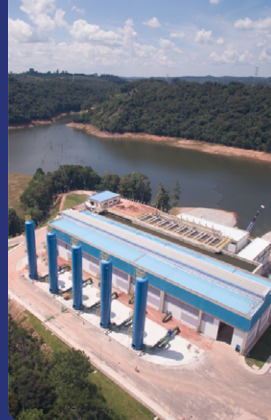
Estrutura de captação do Sistema Produtor São Lourenço, na represa Cachoeira do França, localizada no Vale do Ribeira
