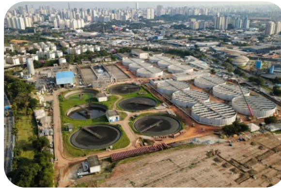
WWTP Parque Novo Mundo
