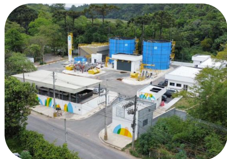
ETE Cabuçu - Guarulhos
