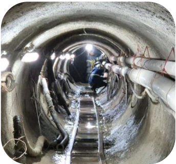
Integra Tietê – Obras lineares
