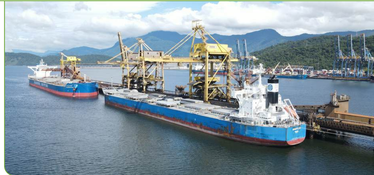
→ Operação de carregamento de minério - Itaguaí (RJ)
