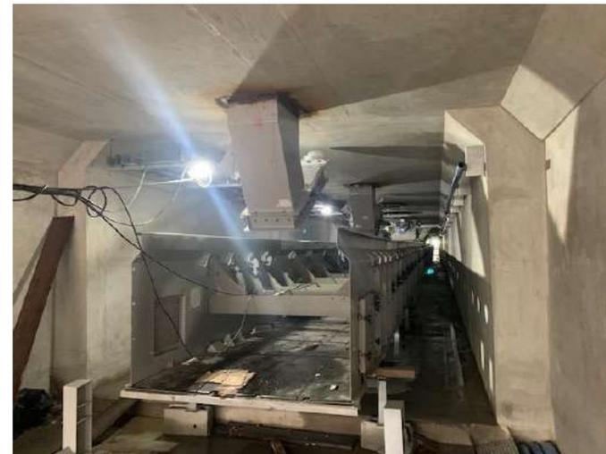
Foto 3: Montagem do TC-203 (Recebimento dos silos)
