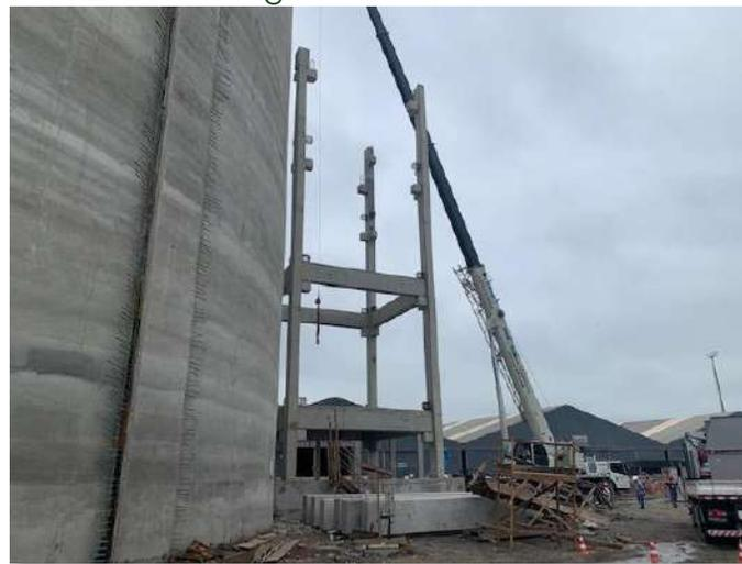
Foto 5: Montagem de estrutura pré-moldada do poço dos elevadores
