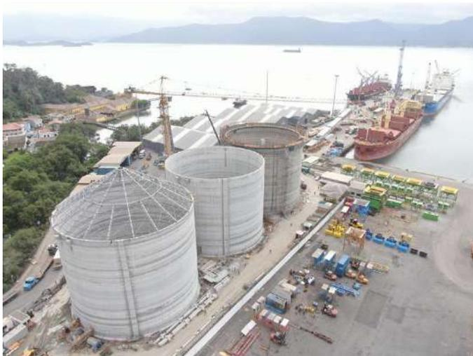
Foto 2: Concretagem dos três silos
