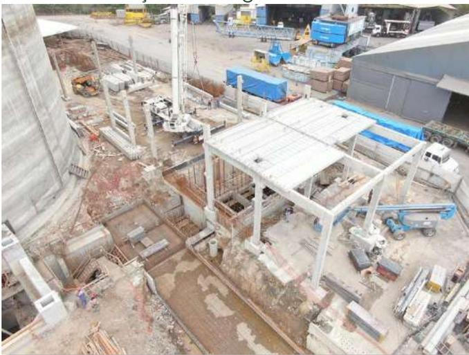
Foto 4: Montagem estrutura pré-moldada da moega rodoviária
