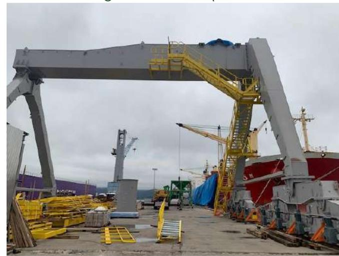
Foto 6: Montagem pórtico inferior do shiploader
