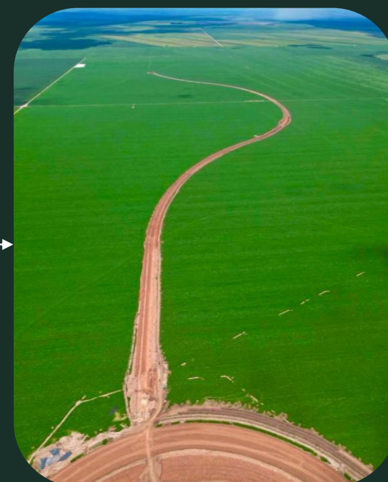
Canal conectando c/ reservatório em construção
