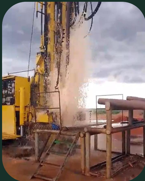
Perfuração poços 300m 3
