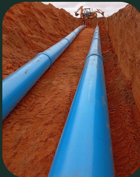
Instalação Adutoras 500mm
