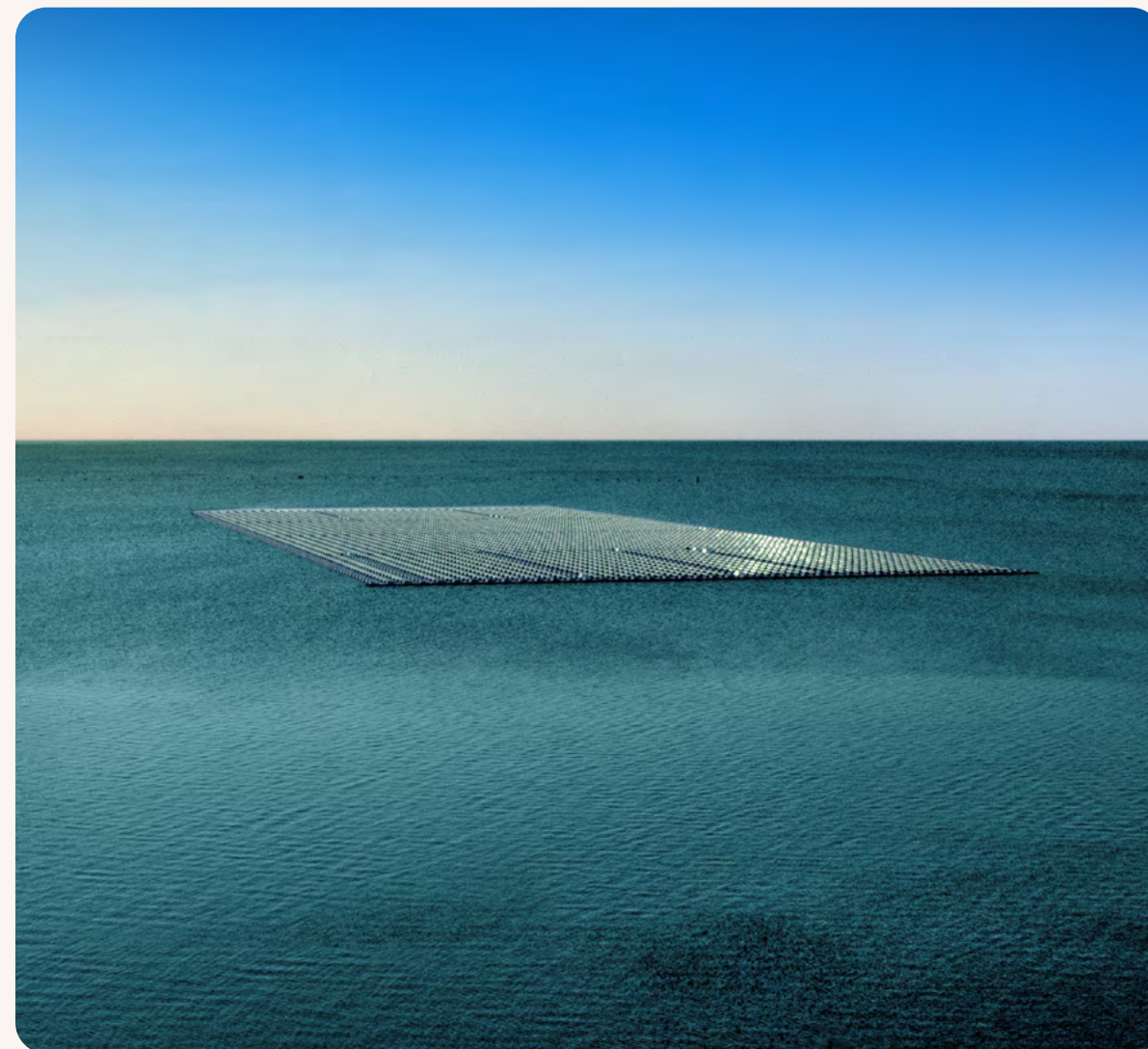
Plataforma Solar Fotovoltaica Flutuante de Sobradinho – Zeca Teixeira
