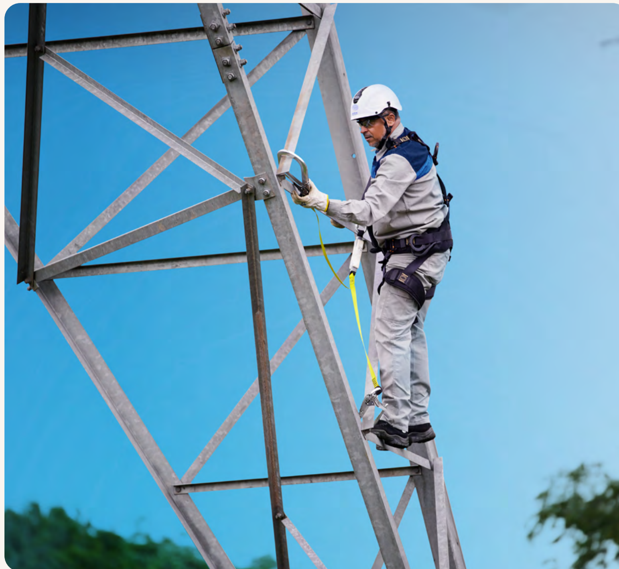
Manutenção em linha de transmissão - Acervo AXIA
