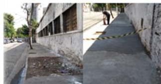
Tapa-buraco na calçada e pintura da parede
