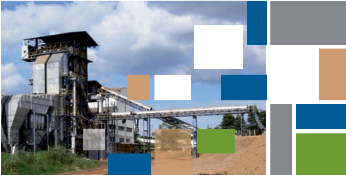
Co-geração energética com utilização de biomassa.
