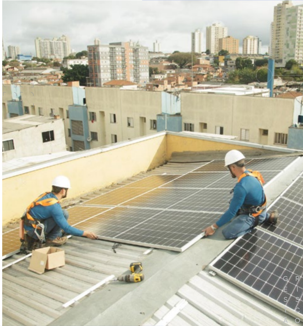
Instalação de placas solares residenciais
