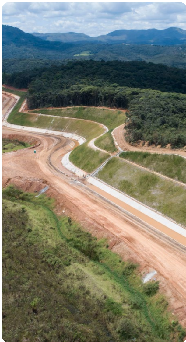
→ Canal de Cintura da Barragem B4 - Congonhas (MG)
