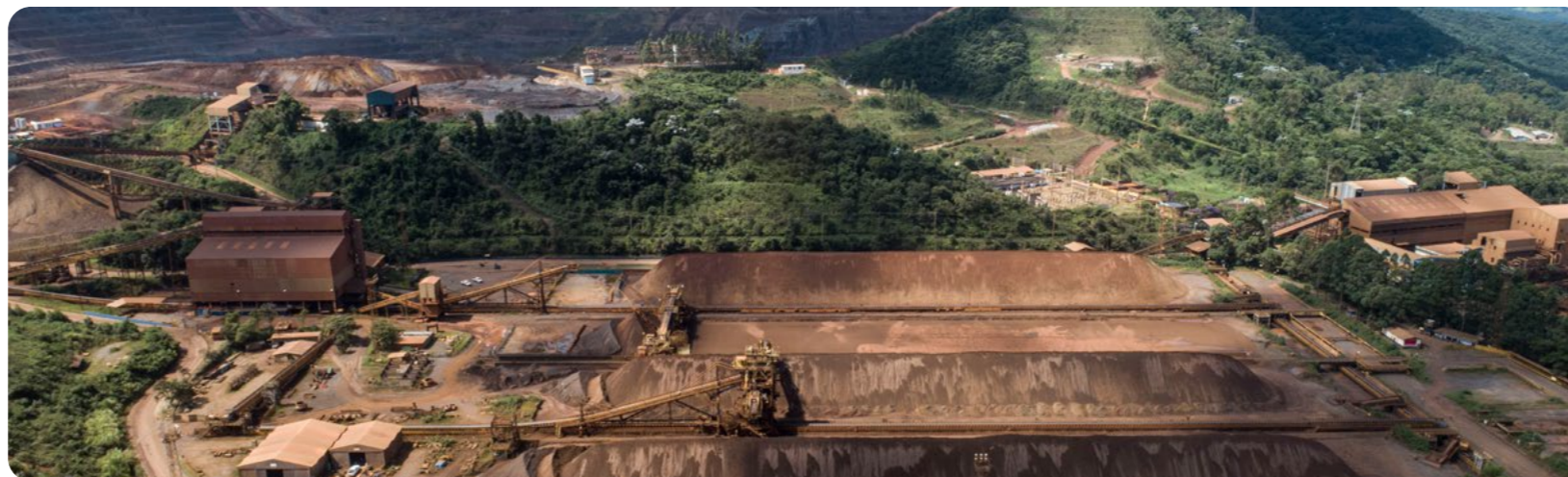
→ Operação de Casa de Pedra - Congonhas (MG)
