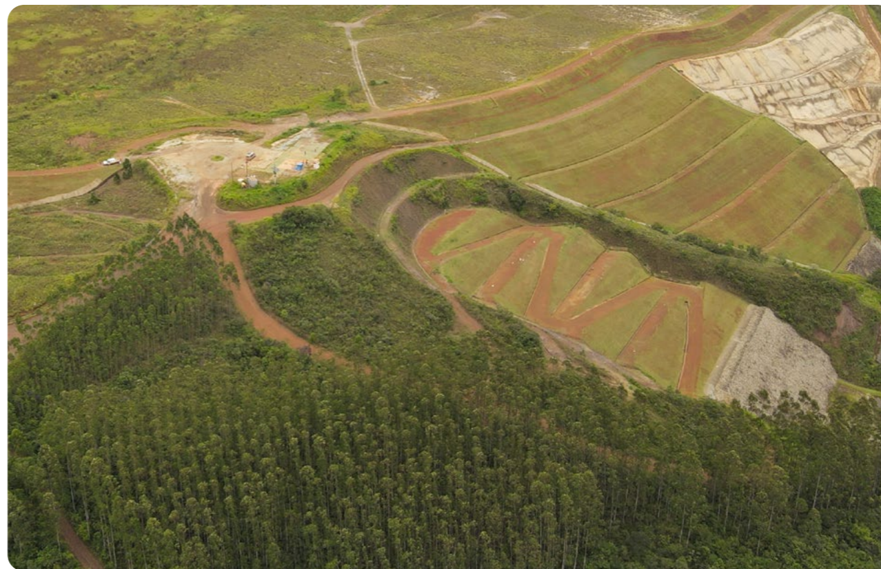
→ Barragem Casa de Pedra - Congonhas (MG)
